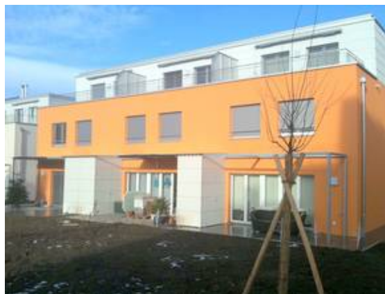
Südfassade REFH Strandbadstrasse 35
